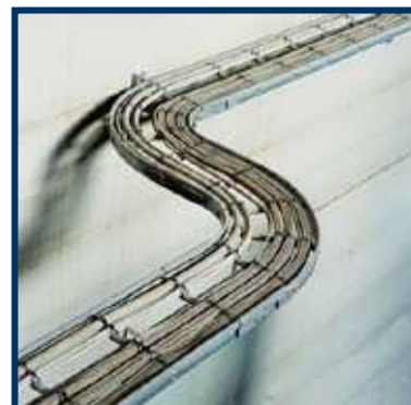
Unha axeitada rede de infraestruturas no polígono é o servizo mellor valorado polos usuarios.
